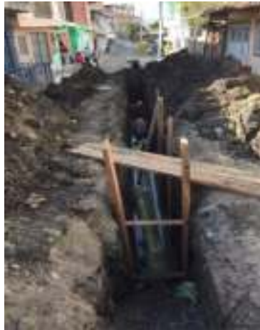
Suministro e instalación de tubería PVC
