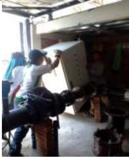
Suministro de tablero de control eléctrico
