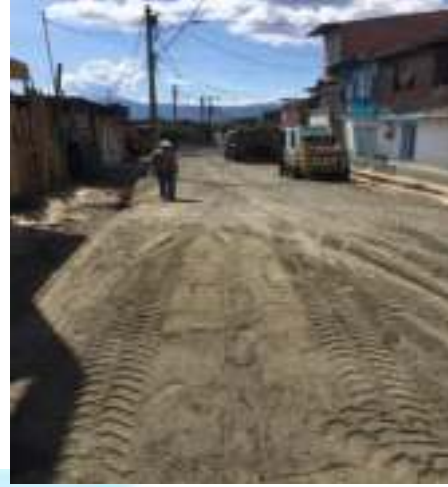
Suministro e instalación de material de base tipo INVIAS
