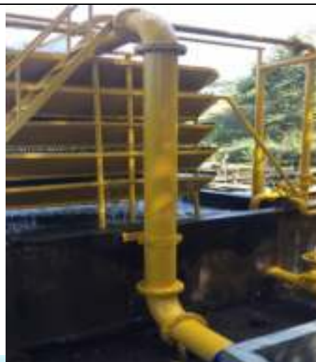
Se observa la llegada del agua del pozo a la PTAP
