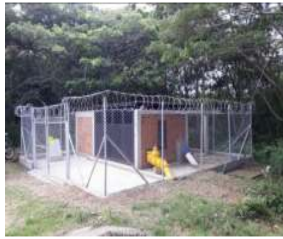
Adecuación de caseta
