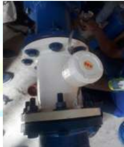
Suministro e instalación de macro medidor
