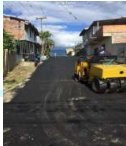
Suministro e instalación de carpeta asfáltica
