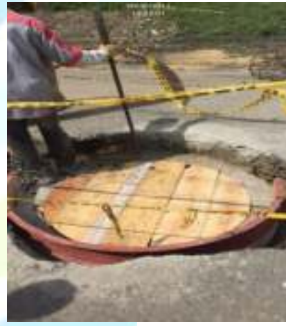
Construcción cámaras de inspección
