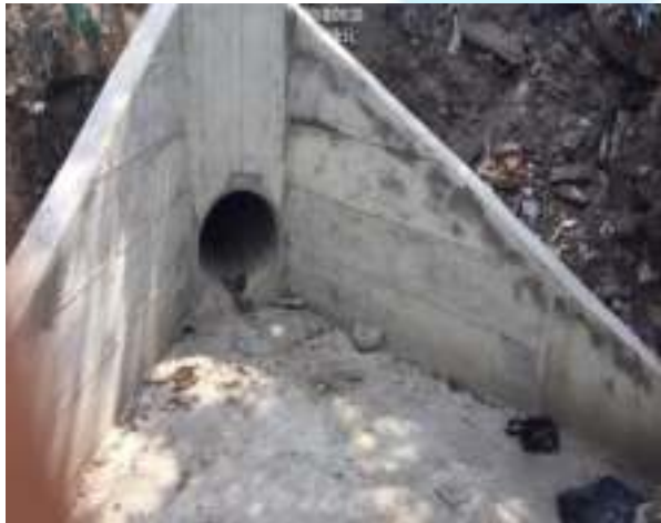
Construcción cabezal de descarga
