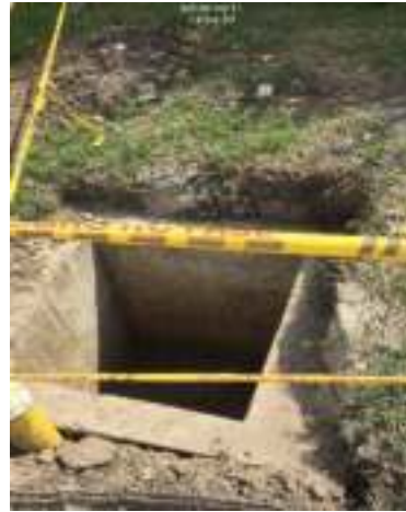
Construcción de Cajas de inspección
